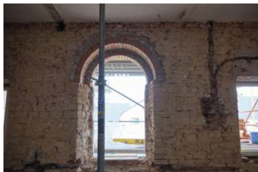
Die wieder hergestellten Rundbogenfenster sind bereits fertiggestellt – Foto: Halsner
