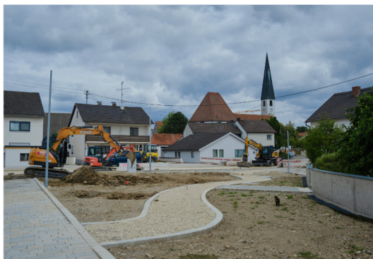
Die Arbeiten an der Ortsmitte gehen in den Endspurt
