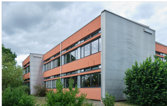
Auf dem Dach der Schule wird die PV-Anlage errichtet
