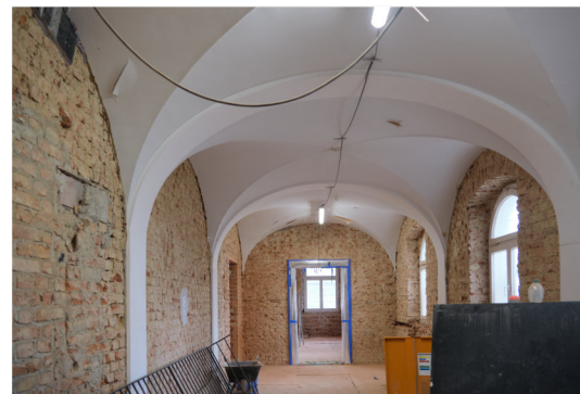
Baustellenfotos: Oben – die Fortschritte im Roßstall sind schon deutlich zu sehen – unten: Gewölbe in der alten Schule
