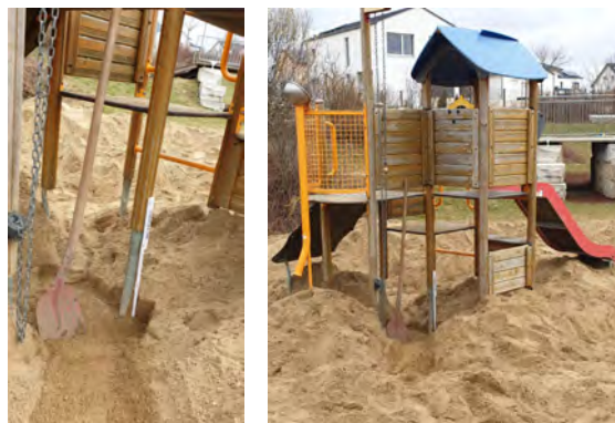
Wie tief die Kinder hier gegraben haben, zeigt der Meterstab an einer der Standbeine des Klettergerüsts
