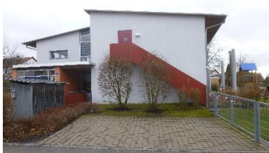
Neubau KITA St. Sebastian
