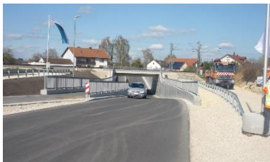
DB-Überführung an der EI 5
