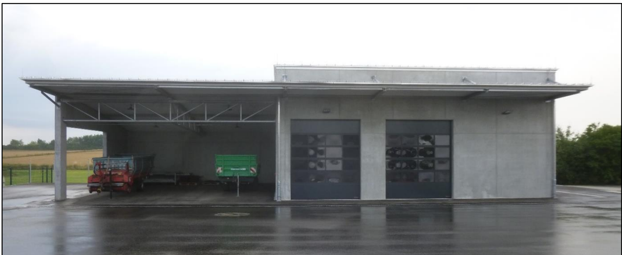
und der Kalthalle (Lagerhalle)
