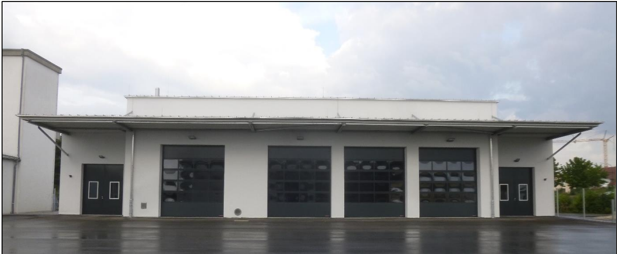
Hofansicht des Hauptgebäudes
