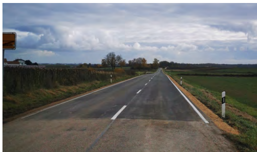
Die Ingolstädter Straße nach der Sanierung.
